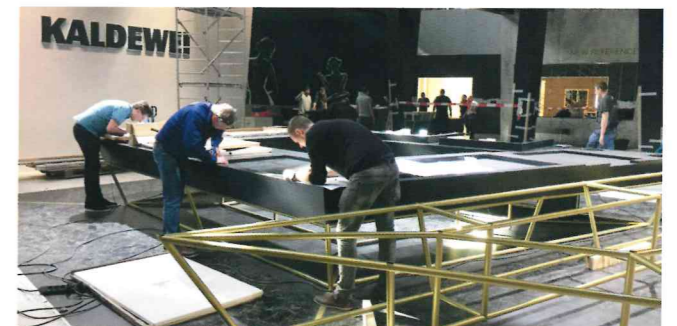
Tag 12: Nachdem die Aufbauarbeiten abgeschlossen sind, beginnt das große Auspacken, Montieren und Anschließen der 45 Produktneuheiten.
