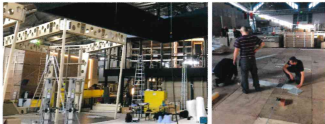
Tag 5: 3.286 m 2 Span- und Dekorplatten (ohne Verschnitt) wurden verarbeitet für Böden, Decken, Stürze und Wände.
