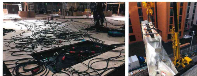
Tag 2: 5,7 Kilometer Strom- und Datenkabel wurden am Messestand verlegt, 175 Scheinwerfer, Schienen- und Einbaustrahler installiert.
